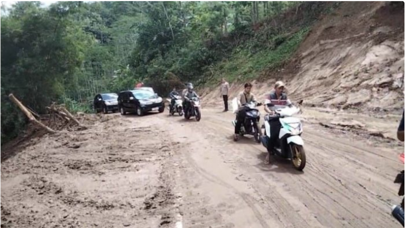
Pembukaan Jalan Selajambe-Cipasung Paska Longsong Yang Menutup Jalan
